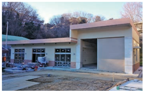
建設中の就労日の出舎(新)作業棟
