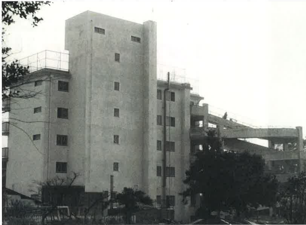
1966年、5階建てになった頃の「泉の家」
